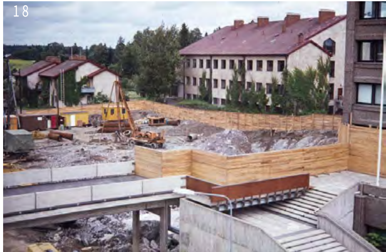
18 Valtuustotalon rakennustyömaa heinäkuussa 1977. Työmaan takana näkyy vuonna 1954 valmistunut arkkitehti Toivo Pellin suunnittelema Lagstadin kansakoulu. Kuvan vasemmassa laidassa näkyvä kansakoulun opettaja-asuntola purettiin vuonna 2006 valmistuneen koululaajennuksen tieltä. Kuvan oikeassa laidassa näkyvä niin ikään arkkitehtitoimisto Castrén-Jauhiainen-Nuuttilan suunnittelema Espoon kaupungintalo (1971) purettiin vuonna 2022. Kuva: Pentti Aalto, 1977. KAMU Espoon kaupunginmuseo.
