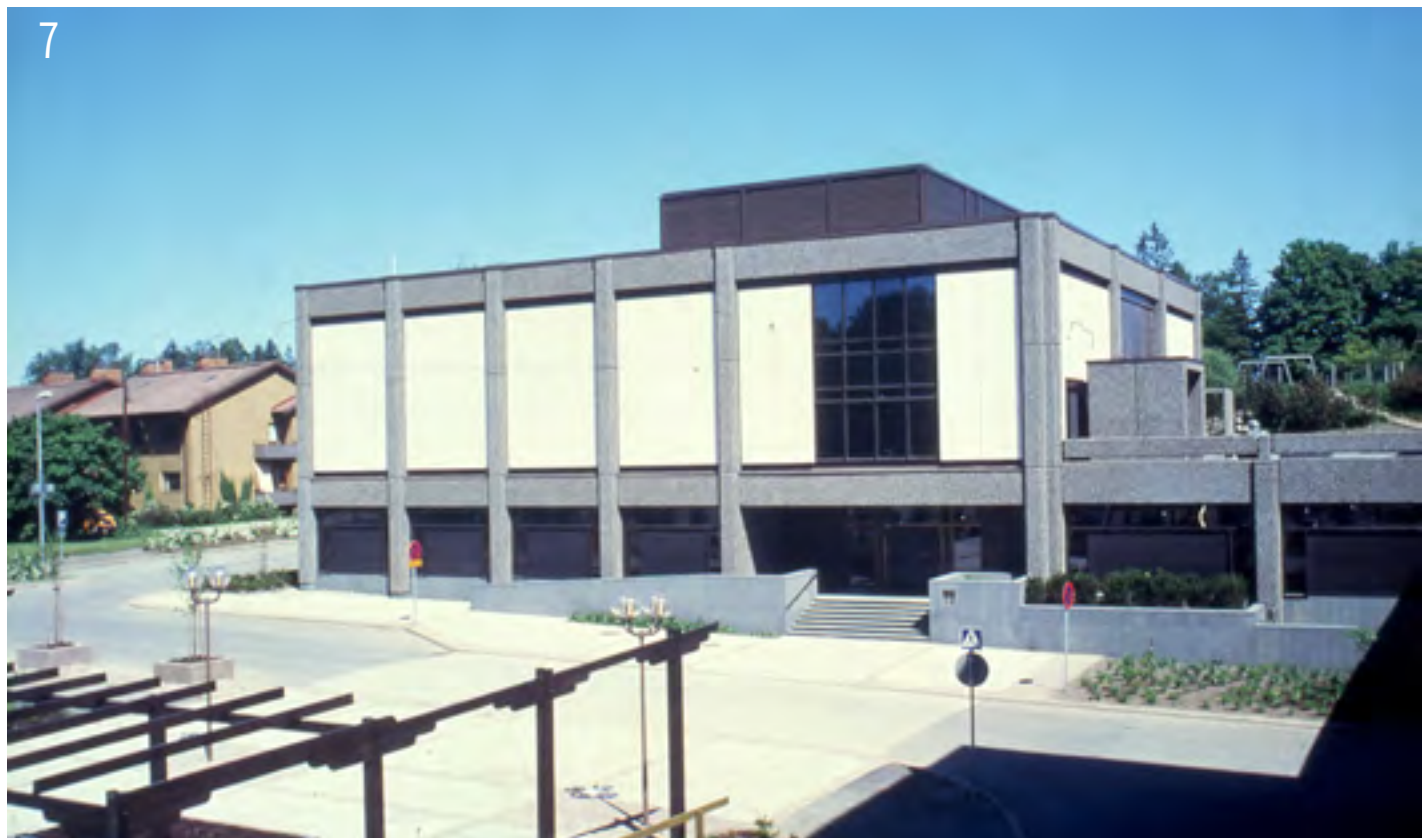
7 Valtuustotalo kuvattuna oletettavasti pian valmistumisensa jälkeen. Etualalla Valtuustoaukio, oikealla ylhäällä hallintoaukio. Taustalla vasemmalla pilkottaa vuonna 2006 valmistuneen koululaajennuksen tieltä purettu kansakoulun opettaja-asuntola. Valtuustoaukiolla kuvassa näkyvät ulkovalaisimet eivät ole säilyneet. Betoniset istutuslaatikot ja puurivi sekä vastaava puinen pergolarakenne kuitenkin löytyvät Valtuustoaukiolta tänäkin päivänä. Vanhan valokuvan kellertävään taittavat sävyt johtuvat oletettavasti kuvausajankohdasta sekä käytetystä kuvauskalustosta. Kuva: Suomen Elinkeinoelämän Keskusarkisto ELKA.
